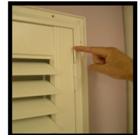
Insert Hinge Pin
